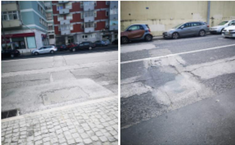
Deixamos igualmente o alerta de que há pelo menos 1 passadeira que se está a deteriorar e necessita de pintura, colocando peões em risco e criando dificuldades aos condutores que podem não se aperceber da sua existência, sobretudo durante a noite quando a iluminação é menor.
